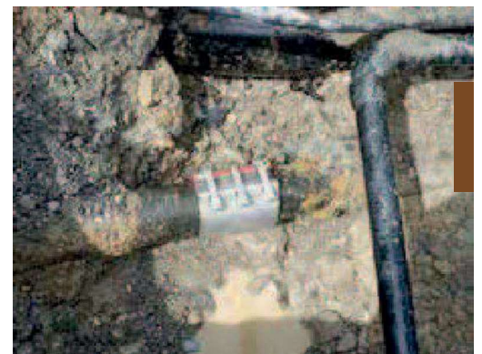
Poškozené místo na potrubí lze rychle a spolehlivě utěsnit pomocí spojky STRAUB-REP-FLEX.
