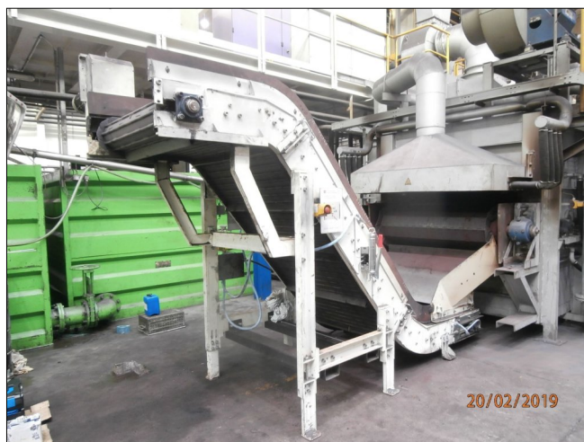
Celkový pohled na dopravník s mazacím systémem
