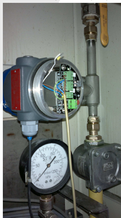
montáž Thermatelu TA2 s impulsním výstupem
