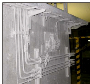
2-2 cestné elektromagnetické ventily pro připojování a odpojování jednotlivých větví systému
