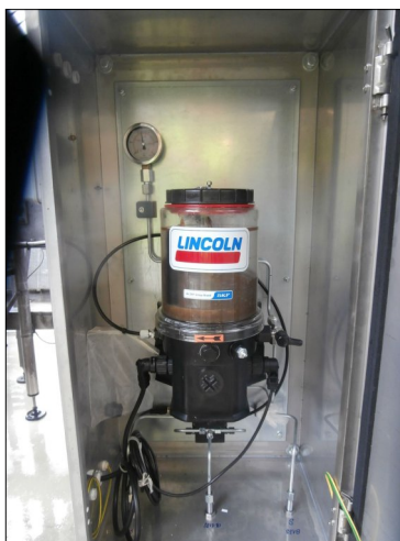
Nerezová uzamykatelná skříň s čerpadlem s příslušenstvím a primárním progresivním rozdělovačem
