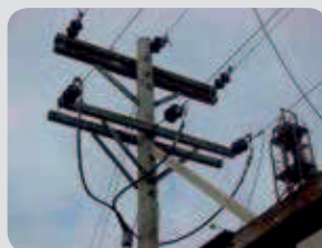
Chyba rozvodného vedení
