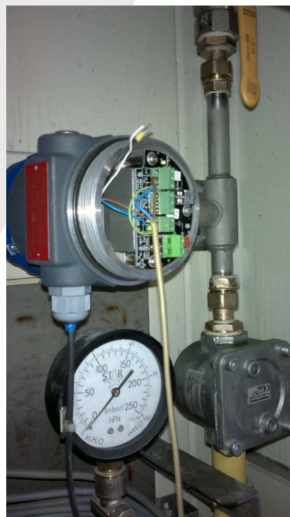
montáž Thermatelu TA2 s impulsním výstupem
