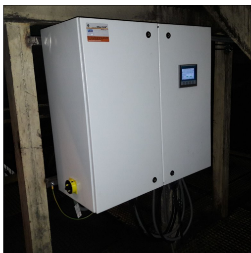
Uzamčená rozváděčová skříň s čerpadlem, ventily a elektroovládáním
