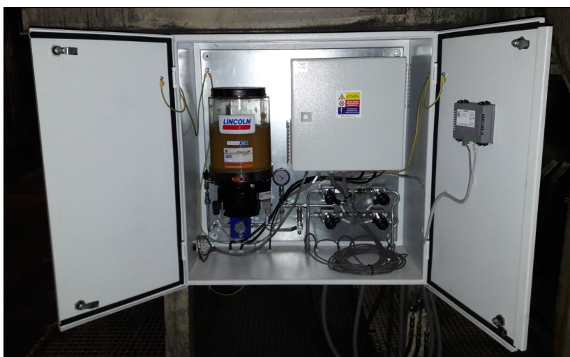
Pohled do rozváděčové skříň
