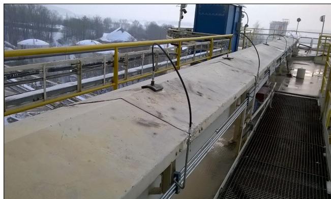
Část nejdelšího dopravníku
