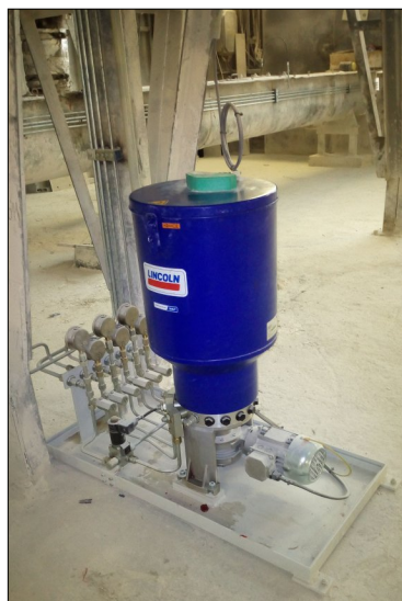
Čerpací stanice s čerpadlem P215, příslušenstvím a elektromag. ventily pro odpojování dvou dopravníků od systému
