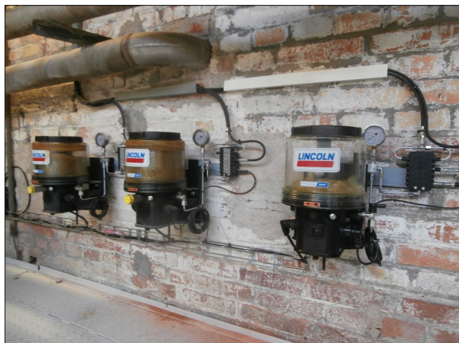
Čerpadla P203 s primárním progresivním rozdělovačem s detektorem pístku
