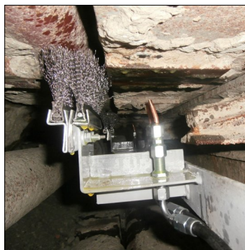
Trysky umístěné na konzole společně s ocelovými kartáči odstraňujícími z řetězu hrubé nečistoty
