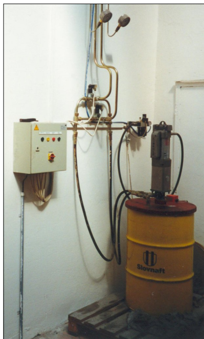
Čerpací stanice - čerpadlo, přeřazovací ventily, řídicí systém
