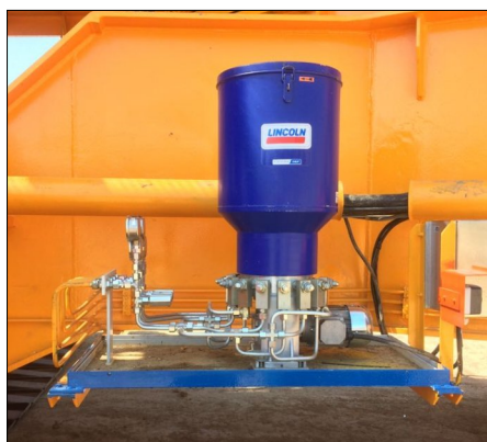
Čerpací stanice s čerpadlem P215
